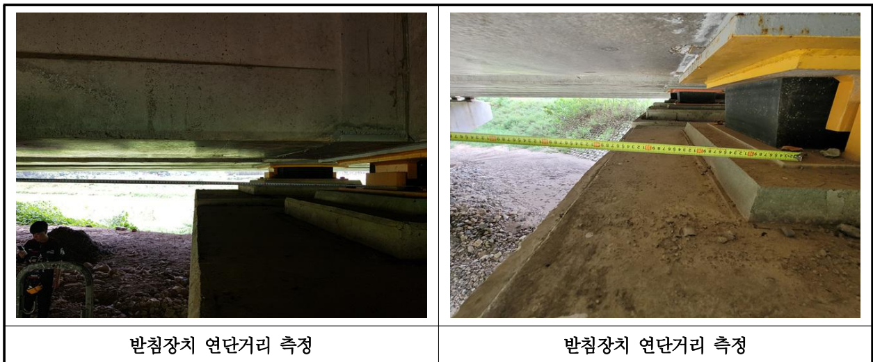
【사진 18.3.42】 교량받침장치 연단거리측정
