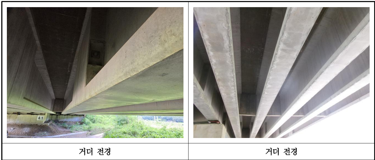
【사진 18.3.4】 거더 전경
