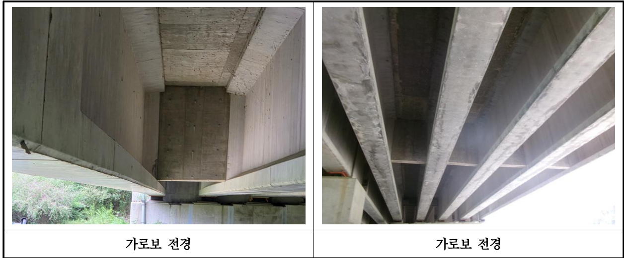
【사진 18.3.33】 가로보 전경
