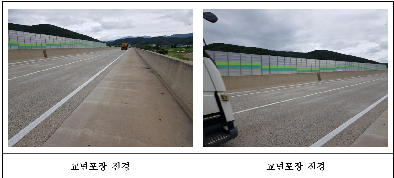
【사진 18.3.47】 교면포장 전경
