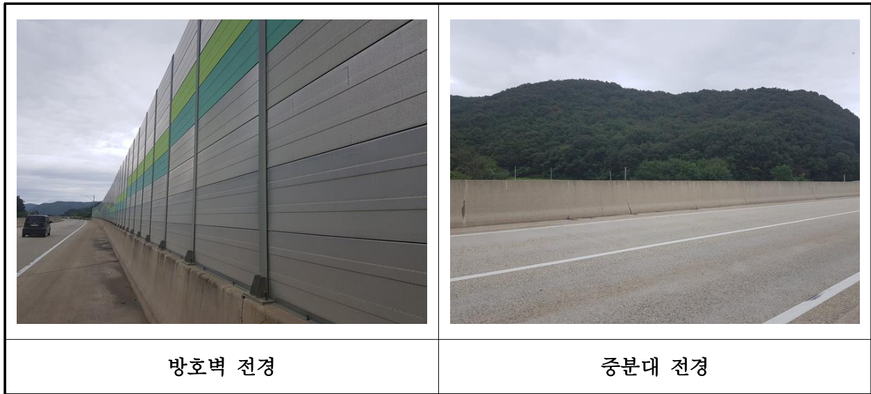
【사진 18.3.24】 방호벽 및 중앙분리대 전경
