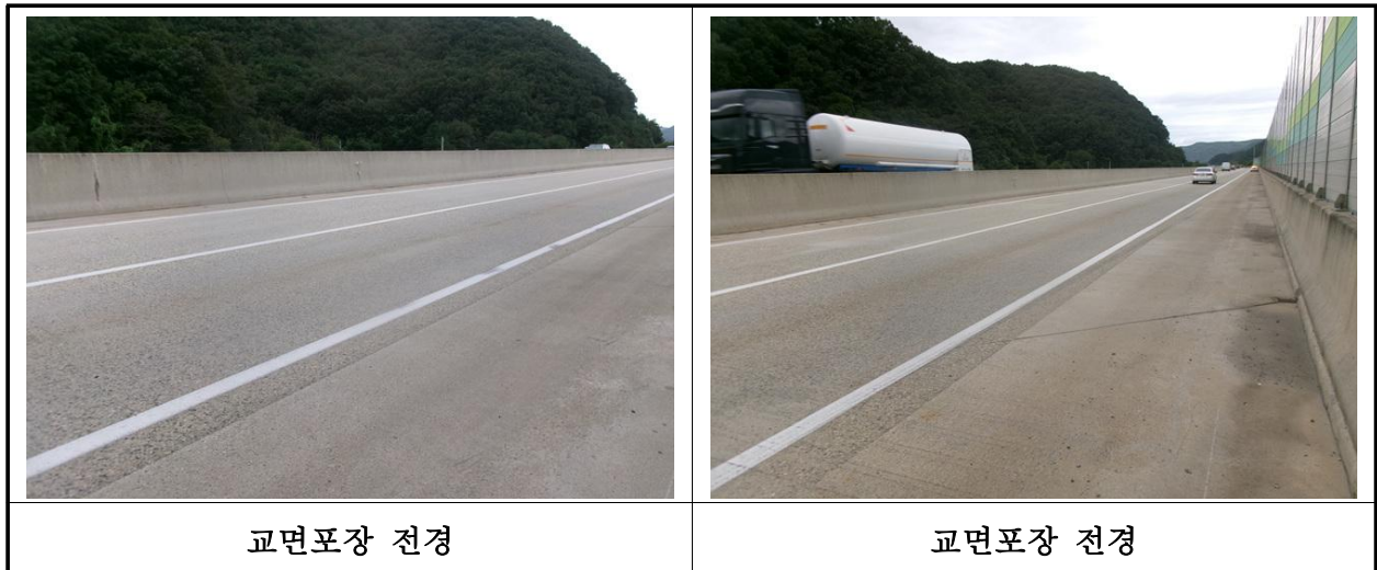
【사진 18.3.20】 교면포장 전경
