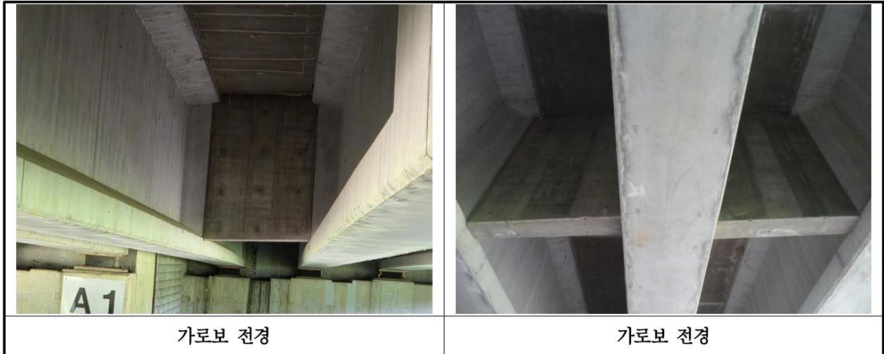
【사진 18.3.6】 가로보 전경
