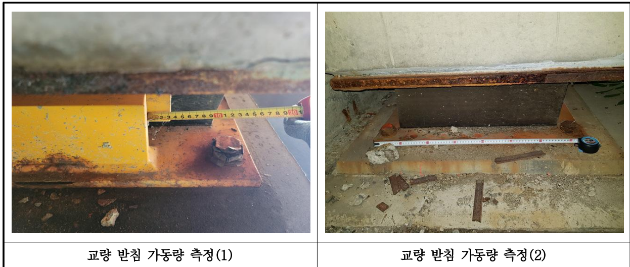
【사진 18.3.16】 교량받침 이동량 측정
