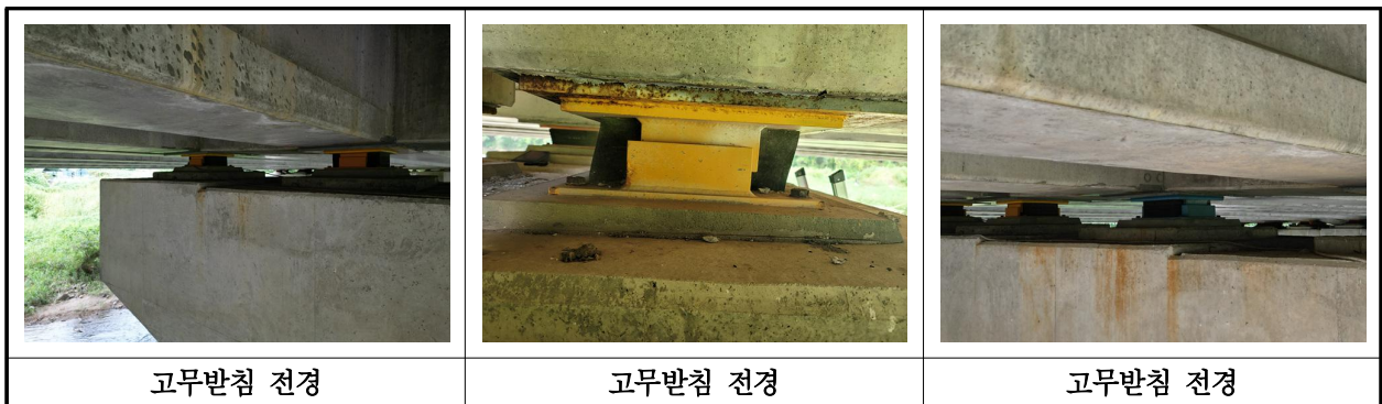
【사진 18.3.13】 교량받침 전경
