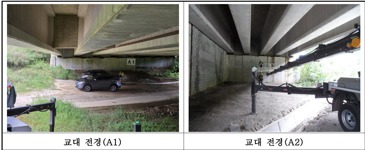
【사진 18.3.35】 교대 전경
