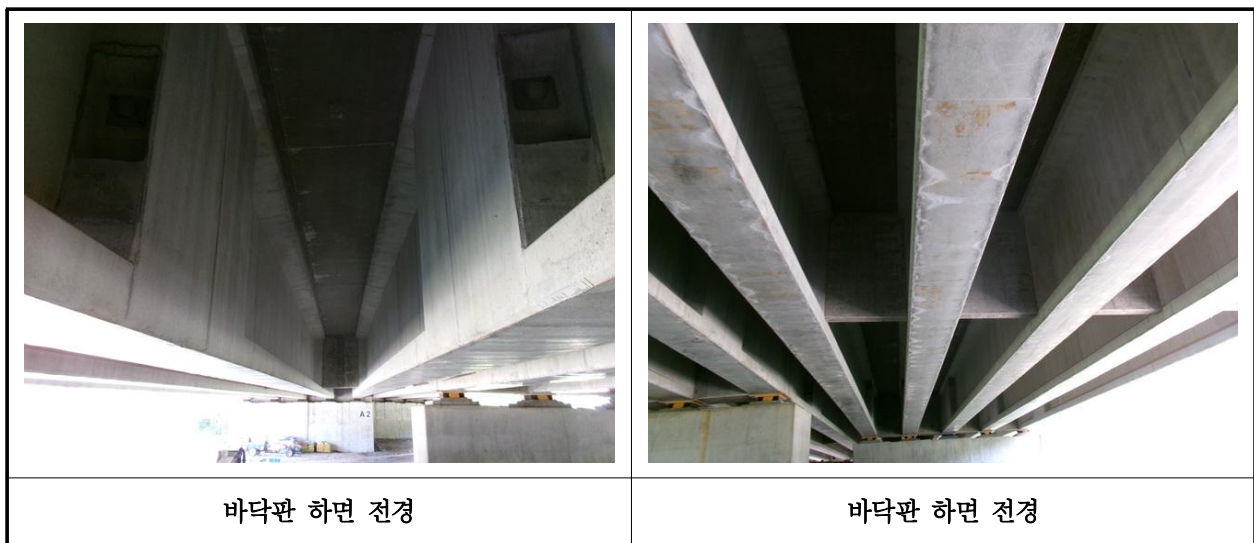
【사진 18.3.2】 바닥판하면 전경
