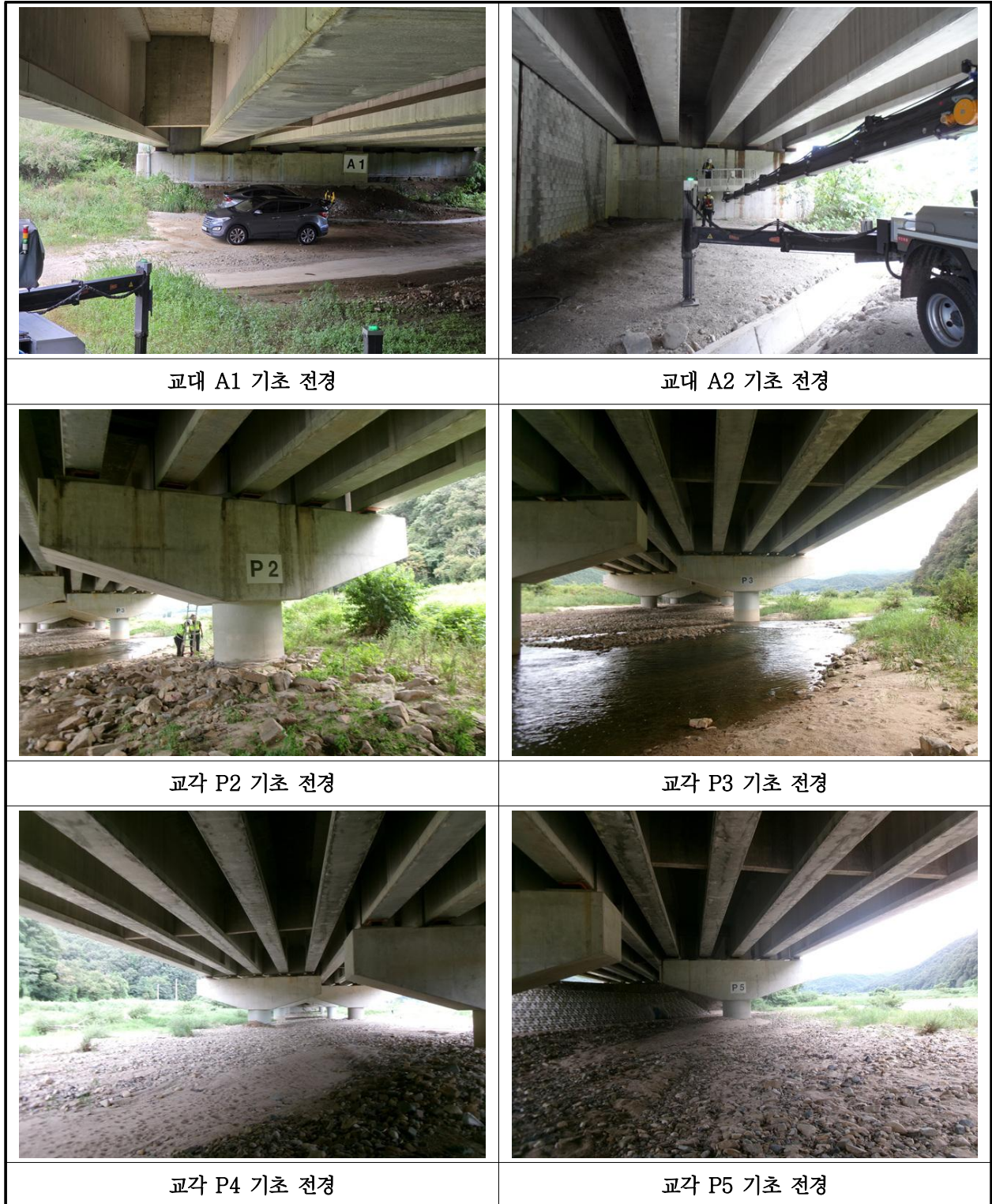
【사진 18.3.39】 기초 전경
