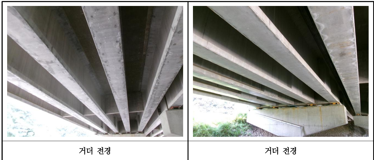
【사진 18.3.31】 거더 전경
