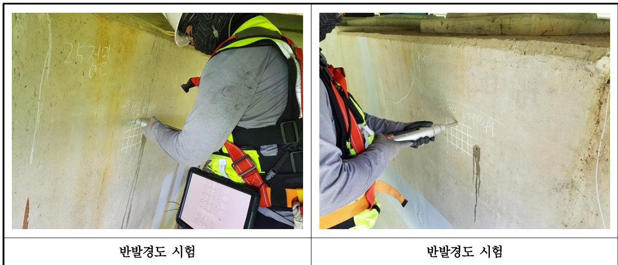
【사진 18.4.2】 반발경도시험 현장사진
