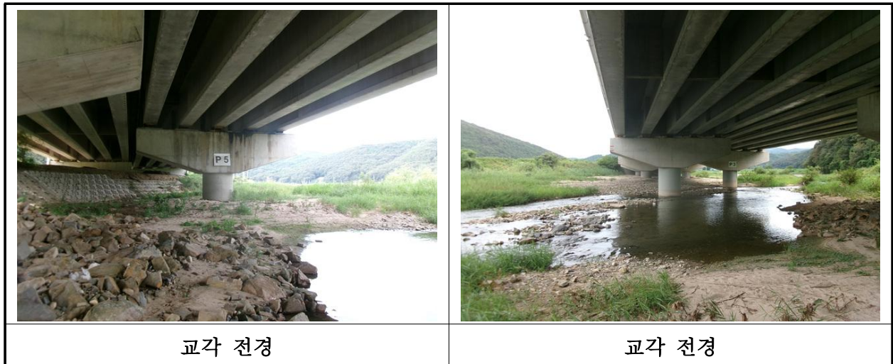
【사진 18.3.10】 교각 전경
