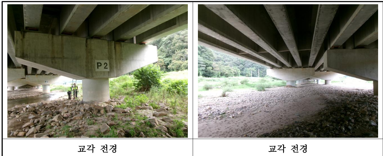
【사진 18.3.37】 교각 전경
